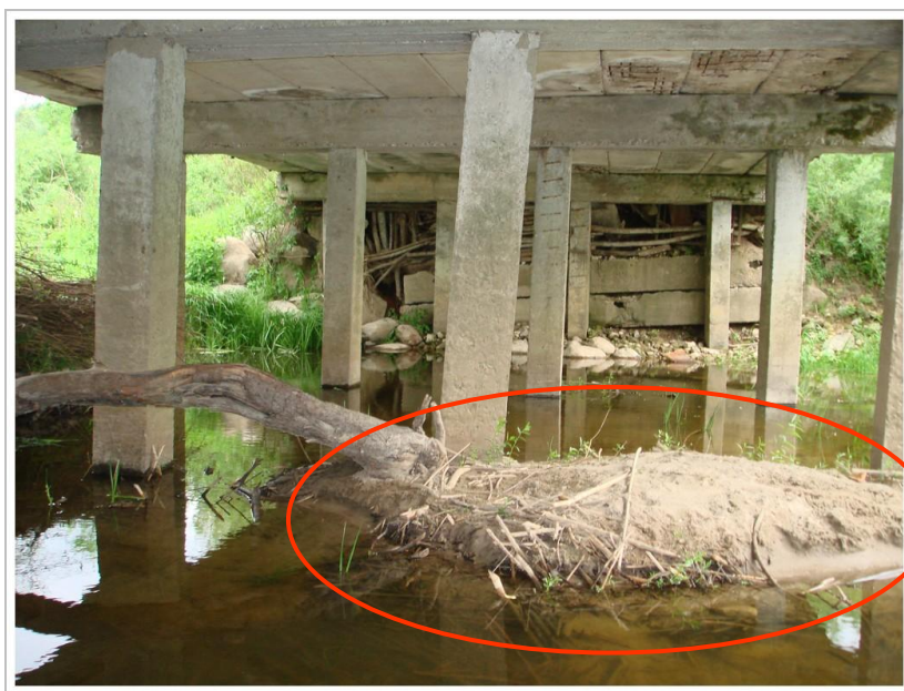
1. fotoattēls Balsta augštece izskalošanās smiltis akumulācijas lejteces pusē, veidojot salu
