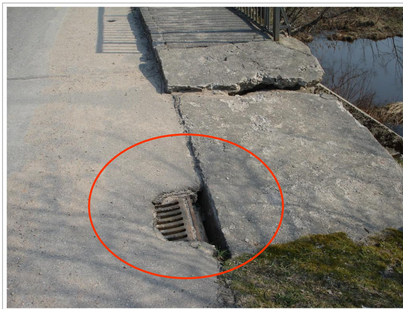
51. fotoattēls Bojājumi uztvergūlījā un iesēdums ceļa seguma konstrukcijā (pirms iebrukuma)
