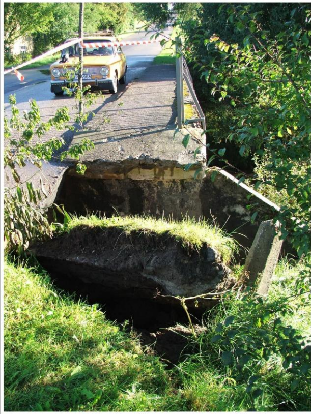
52. fotoattēls Pēc lielām lietusgāzēm 3 mēnešus vēlāk iebrucis ceļa segums
