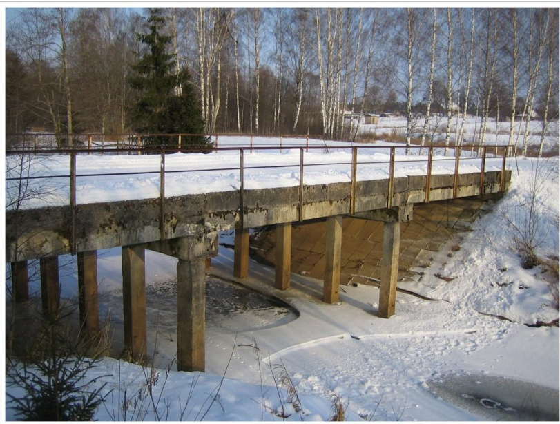
15. fotoattēls Tipveida saliekamo dzelzsbetona plātņu tilts uz pāļu pamata
