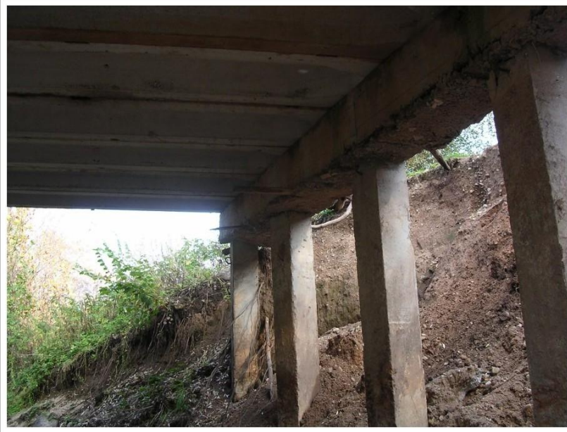
10. fotoattēls Konusa nostiprinājums nav bijis izbūvēts vai arī ticis noskalots
