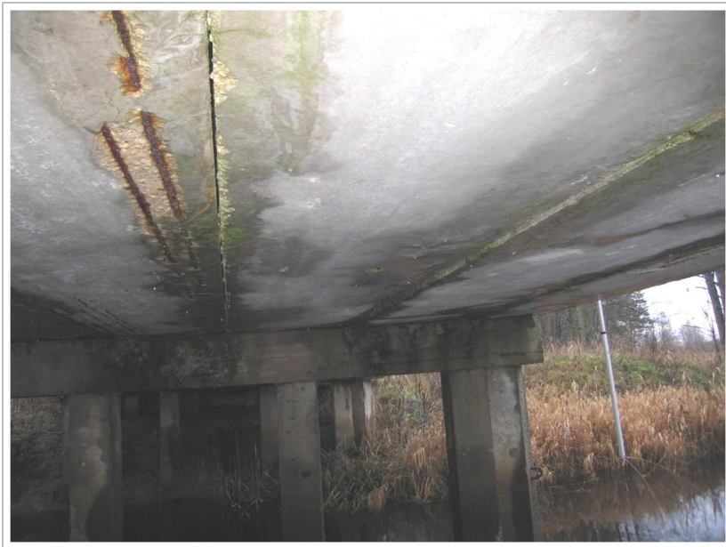
17. fotoattēls Tipveida saliekamās dzelzsbetona plātnes ar elementa platumu 980 mm
