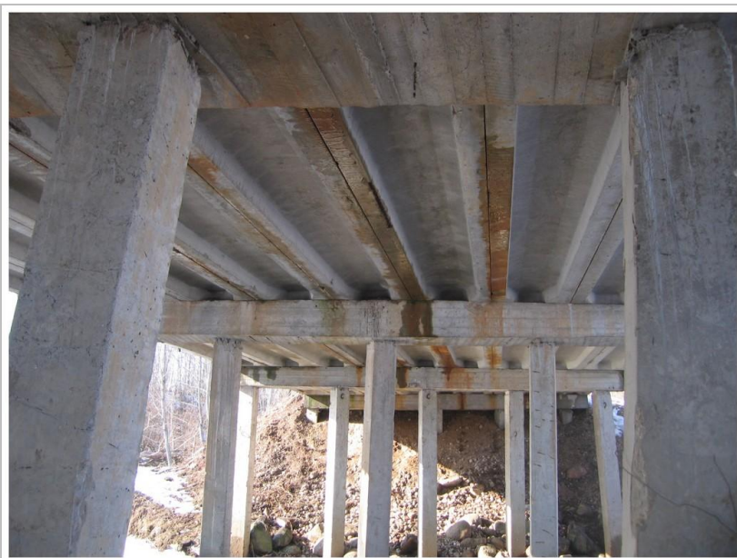
18. fotoattēls Ribotās saliekamās dzelzsbetona plātnes
