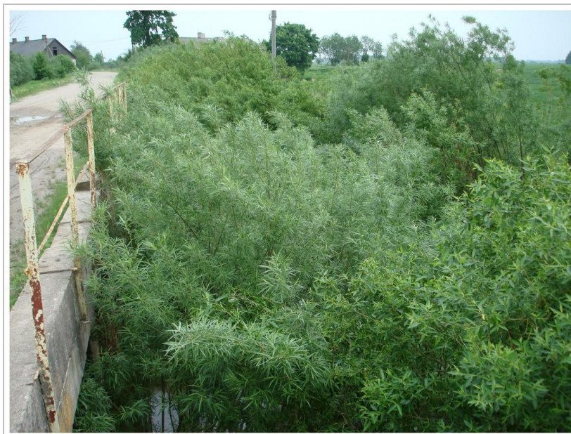
55. fotoattēls Krūmi aug cieši blakus tilta konstrukcijai, neļaujot tai izžūt
