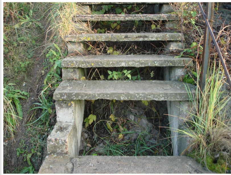
53. fotoattēls Kāpnēs trūkst pakāpienu
