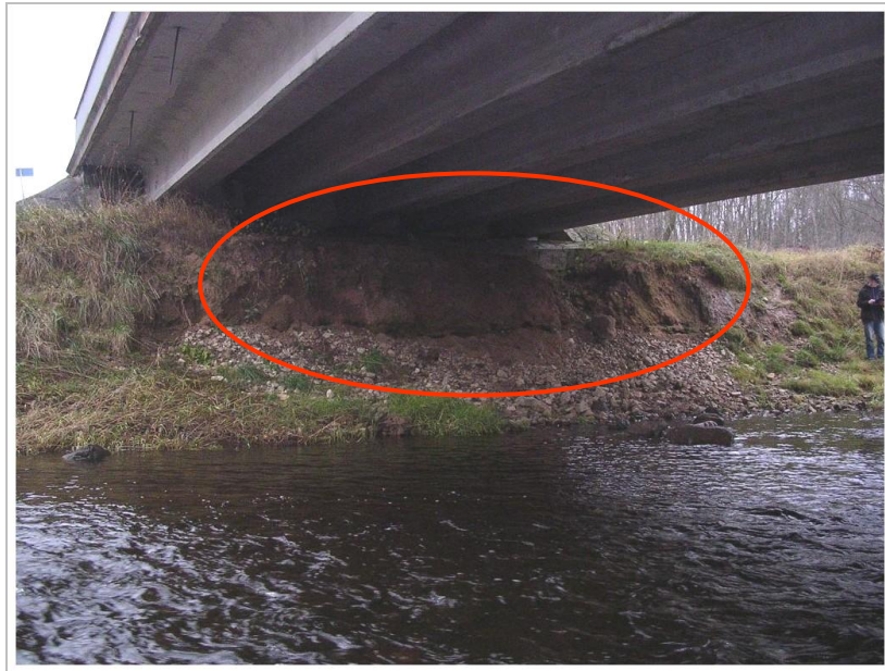
3. fotoattēls Paskalots krasta balsta pamats, balstīts uz dabiskā pamatojuma
