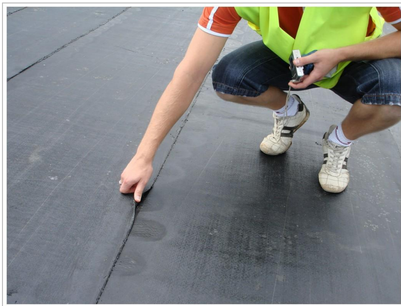
42. fotoattēls Iekļāta ruļļveida hidroizolācija pirms nākamās kārtas izbūves
