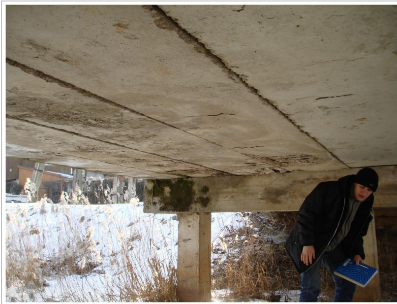
16. fotoattēls Tipveida saliekamās dzelzsbetona plātnes ar elementa platumu 625 mm
