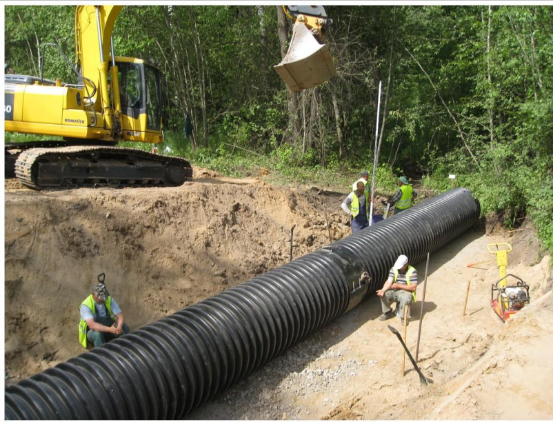
36. fotoattēls Plastmasas caurtekas iebūves darbi
